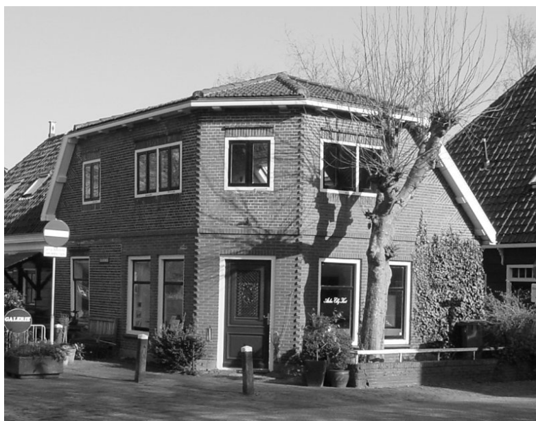
Herstel van de oorspronkelijke gevelindeling van Eilandweg 5a.
