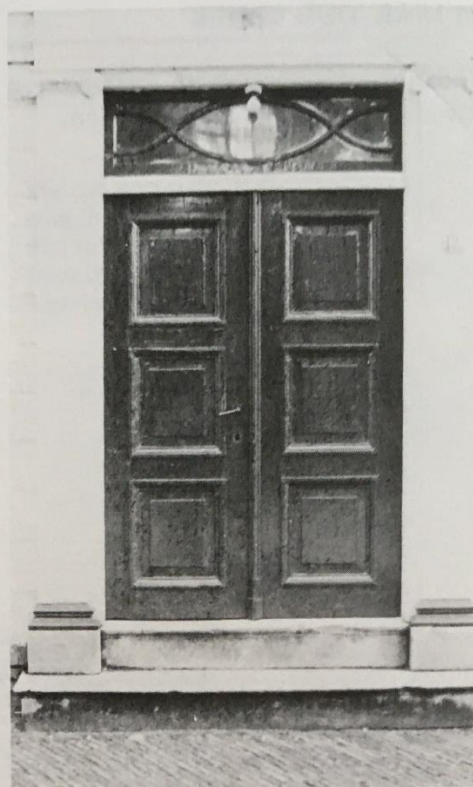
De ingang van de Leerkamer; het rechter pilasterbasement werd door 'Oud Broek' hersteld in 1968.
