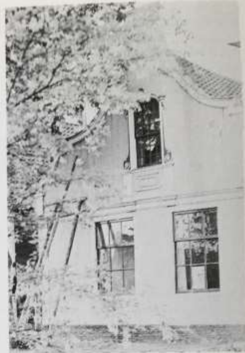
Dezelfde gevel in de oude toestand. Deze idyllische foto laat niet zien hoe slecht de gevel er in feite aan toe was.
