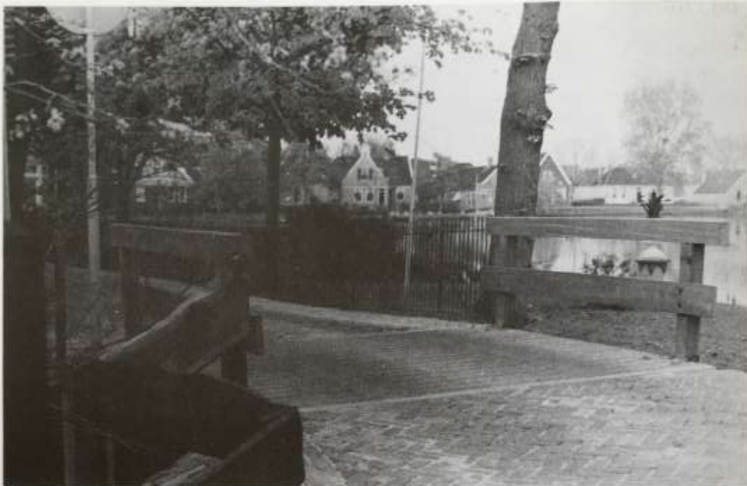
De brug bij De Erven 26
