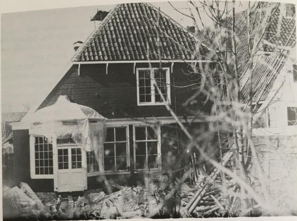
Laan 22-28, gezien vanaf de S10.
