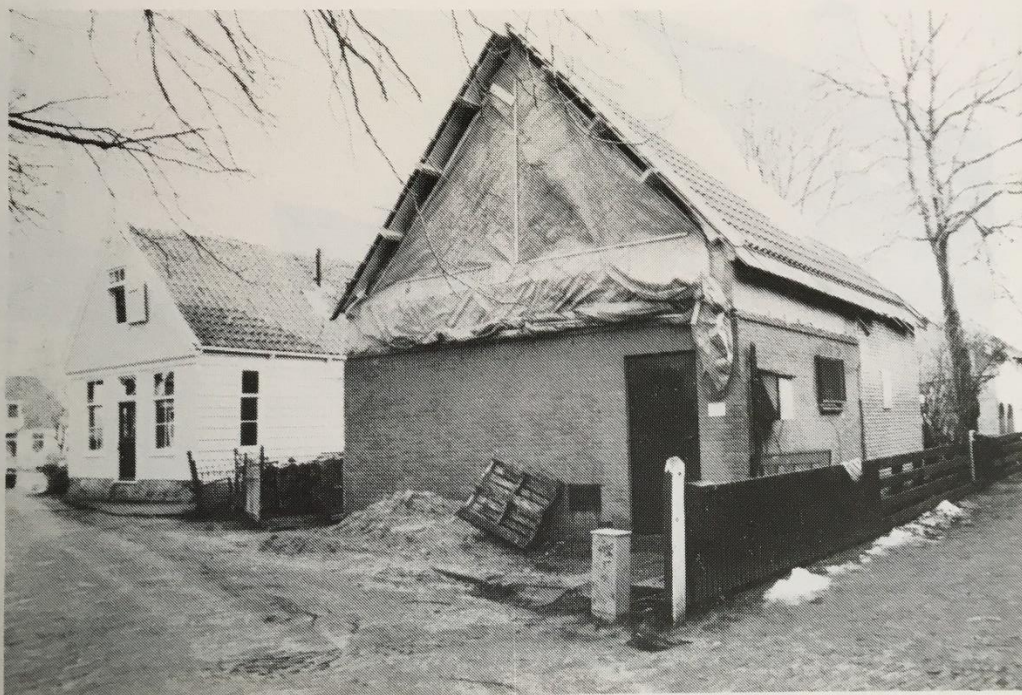
Het PTT gebouwtje tijdens de renovatie
