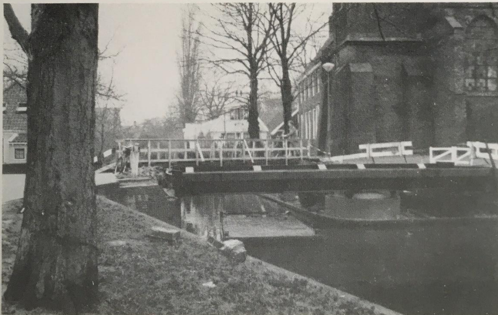
De Kerkbrug tijdens de werkzaamheden.
