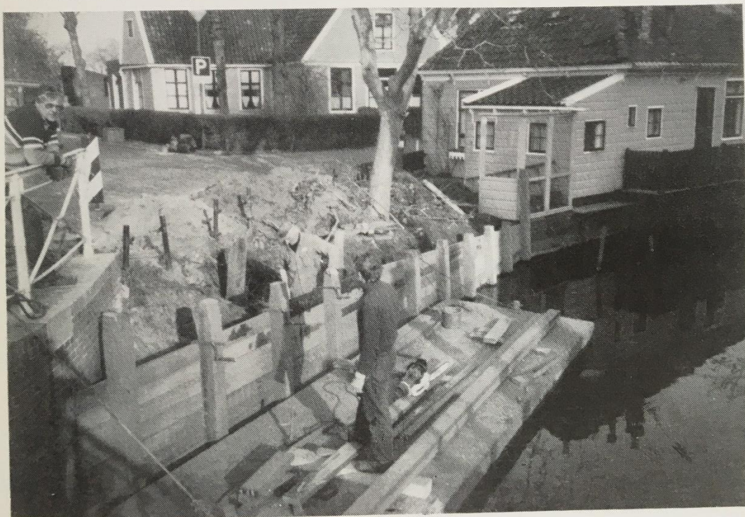
De houten beschoeing in aanbouw
