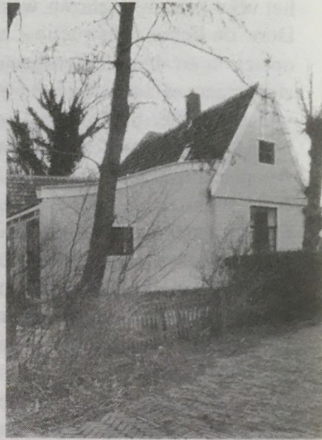
Het gerenoveerde hoekhuis Roomeinde 1
