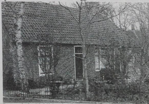
Roomeinde 10 bij het begin van de verbouwing
