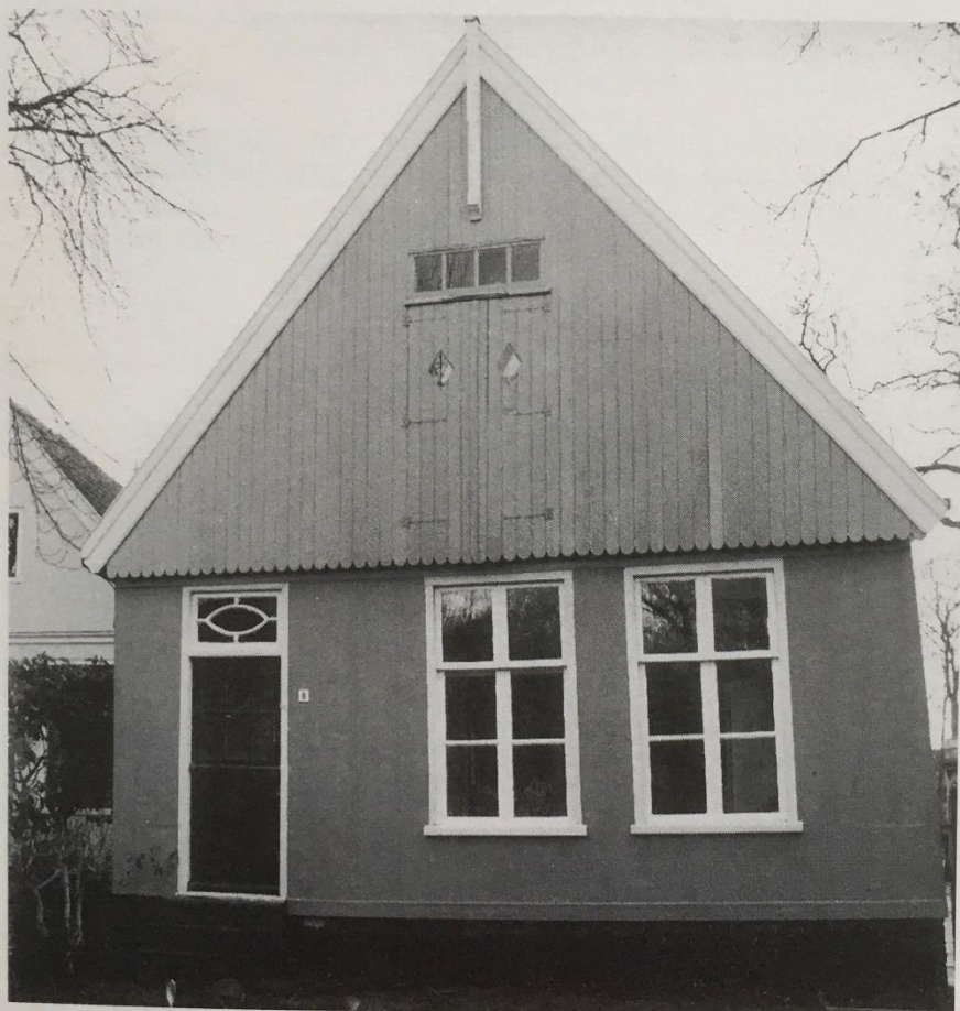
Leeteinde 8 voor de restauratie.
