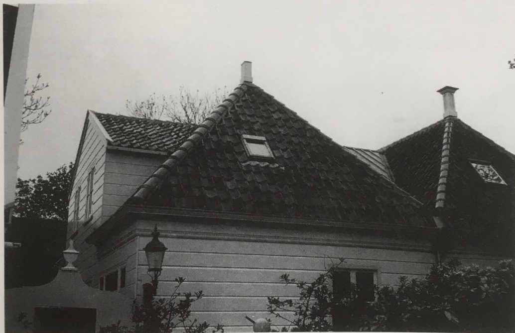
Dakconstructie van Havenrak 37 vanuit het noordwesten gezien
