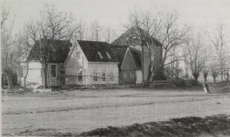
Restauratie en uitbreiding van De Erven 38
