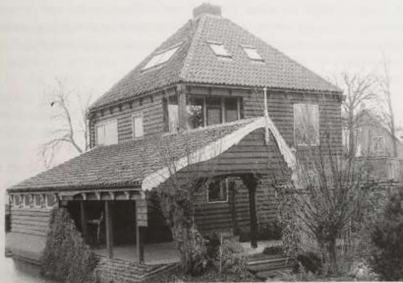
Nieuwe luifel aan woonhuis Noordmeerweg 16 (Foto: J. de Waal).
