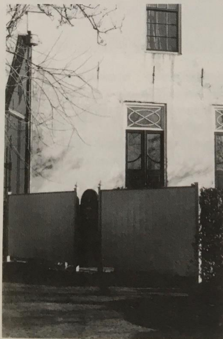
Houten erfscheiding, achterzijde De Erven 2 (Foto: J. de Waal)
