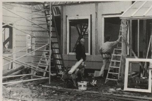
Restauratie c.q. verbouwing van Keerngouw 2 (Foto's: J. de Waal)
