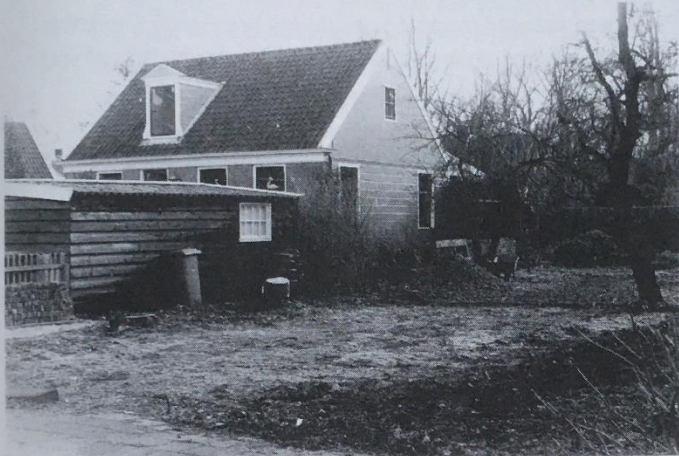
Sloop van het schuurtje aan de Keerngouw (dat in de 70er jaren bekendheid kreeg als peuterspeelzaal en katholieke kerk) om plaats te maken voor een grotere houten schuur. (Foto: J. de Waal)
