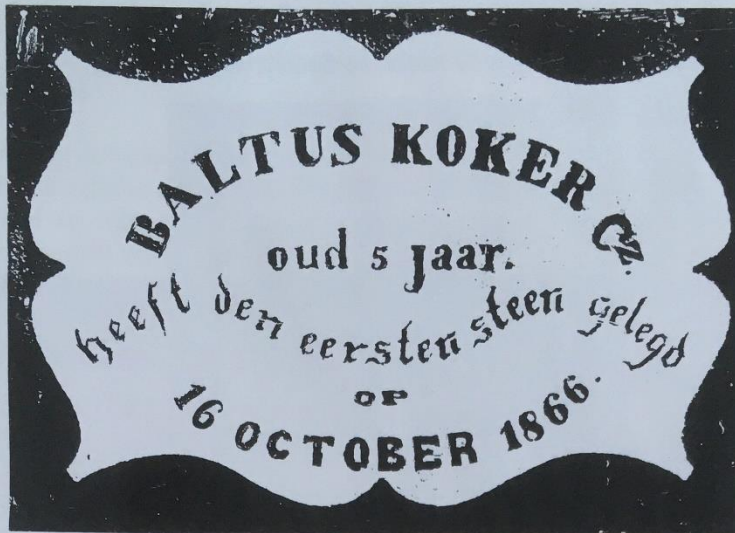
4. In de voetingmuur aan de slootzijde van het bijgebouw achter De Erven 26.
