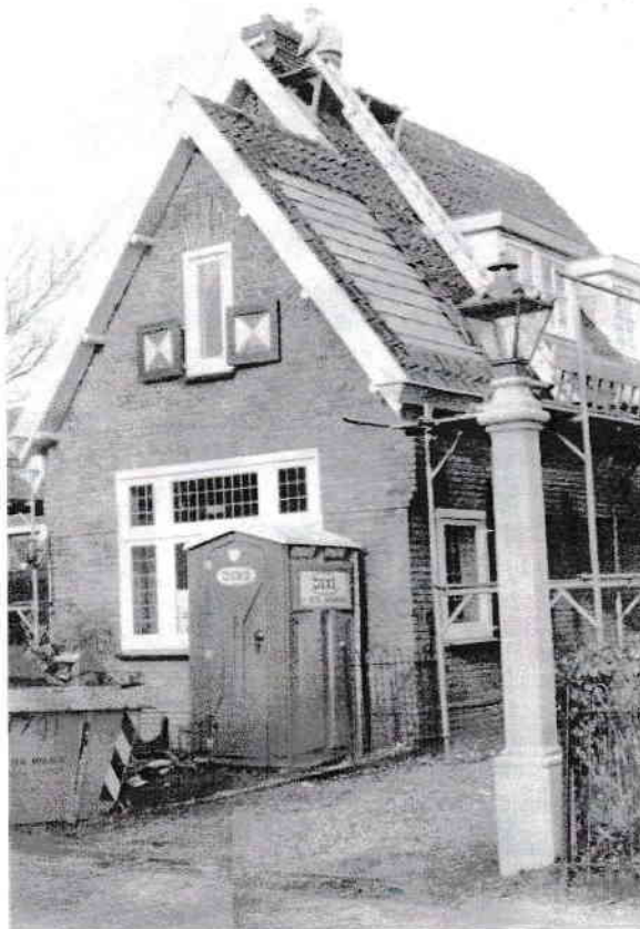
Eind 2008 is begonnen met restauratie van 'Keerngouw 1'.
