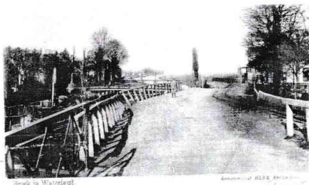
Het houten hekwerk langs de Eilandweg rond 1900. Ook destijds (al) gedeeltelijk verzakt.
