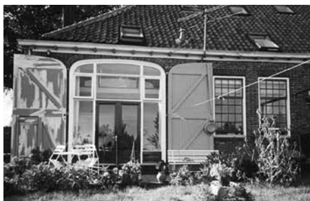
De Geinhoeve na de verbouwing.
