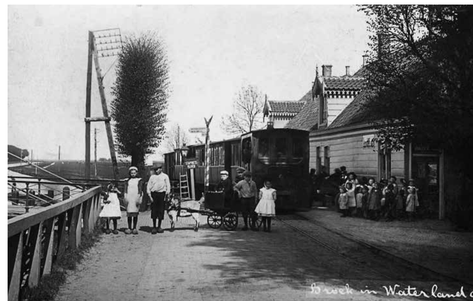
Foto vóór 1906 van E.H. Stöve van het tramstation aan Eilandweg met stoomtram.
