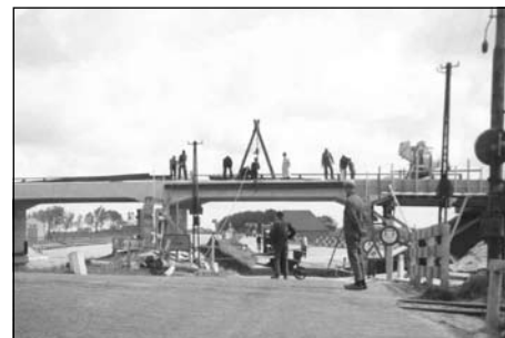
Viaduct bij Het Schouw
