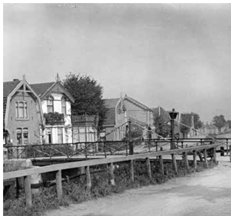
Draaibrug tussen Eilandweg en Jaagweg.
