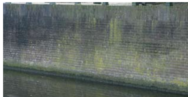
Bakstenen beschoeiing, Monnickendam
