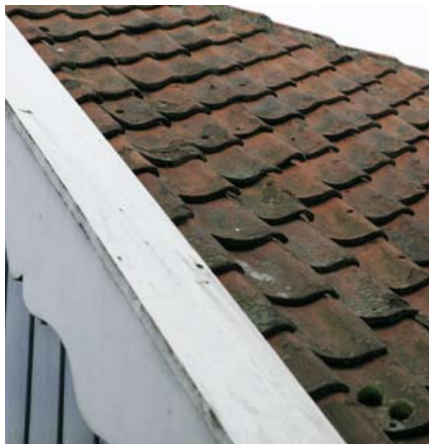
Dak met windveer en bedekking met gegolfde Hollandse pannen
